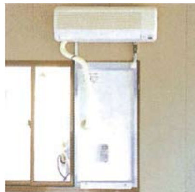
窓枠エアコン
